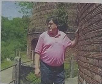
Mina Catalina. Sus hornos de calcinación de mineral de hierro (1955-1960), de 20 metros, «se cerraron en los años 70 porque dejaron de ser rentables».
